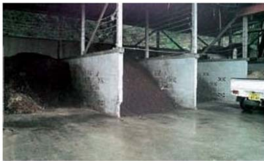
写真Ⅱ-52 地域・自家資源を活用する堆肥化施設
