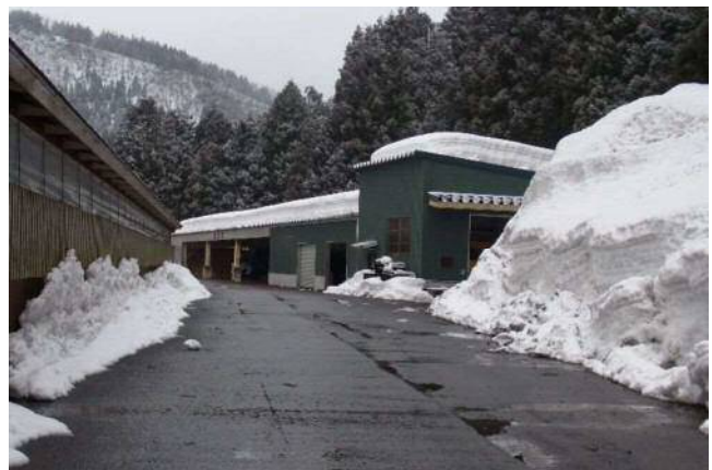
「食 U ターン事業」により町内の家庭から回収された生ゴミを利用した堆肥を製造する池田町あぐりパワーアップセンター
