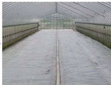
5 被覆中の様子 (被覆資材は地面にしっかり貼り付くように)
