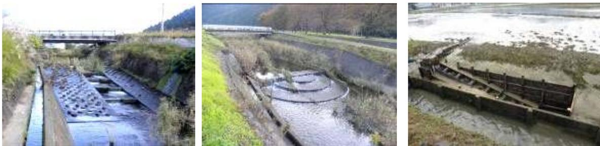
河川に設置された魚道      堰に設置された段差の軽減措置      排水路に設置された水田魚道
