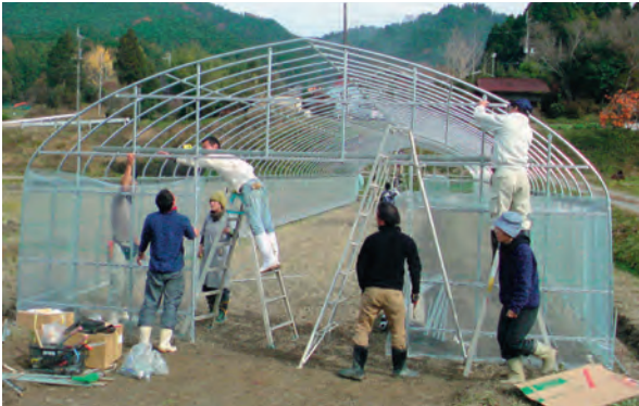
ハウスの建設を学ぶ研修生
