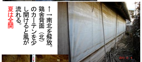
← 鶏の頭を風が通るような空気の循環を考えた構造
