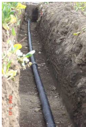
自前で暗渠排水を設置。深さ 80 cm に透水管を設置後、モミガラを敷き埋め戻す。
