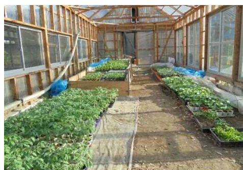
木材とポリカーボネートで作った温室。ビニールの張替えが不要
