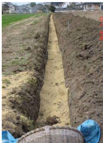
自前で暗渠排水を設置。深さ 80 cm に透水管を設置後、モミガラを敷き埋め戻す。
