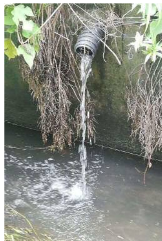
自前で暗渠排水を設置。深さ 80 cm に透水管を設置後、モミガラを敷き埋め戻す。
